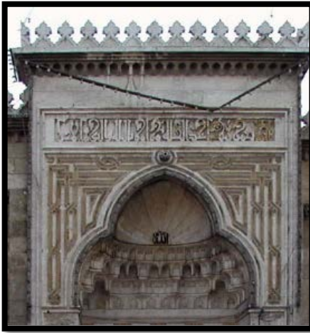
الصورة (10) زخارف المدخل الشمالي [1]
