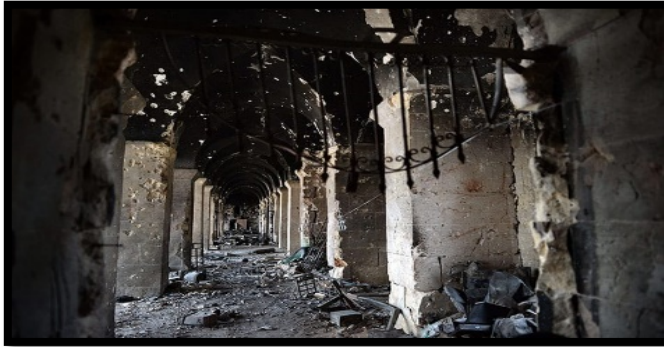
الصورة (14) الحريق في الرواق الشمالي [11]
