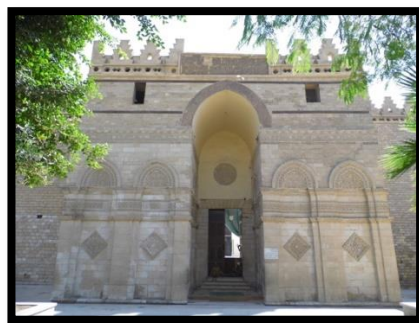
الصورة (1) المدخل الرئيسي في الواجهة الشمالية الغربية 1
